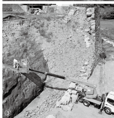
①重機での石材撤去作業 ②石材ごとにカルテを作成 ③高所作業車を使用した石垣背面丘陵部の調査
