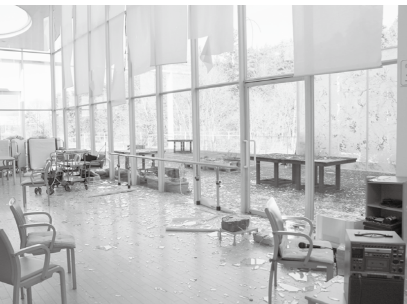
△割れた窓ガラスが飛び散り、悲惨な状態に（東保健福祉センター）
