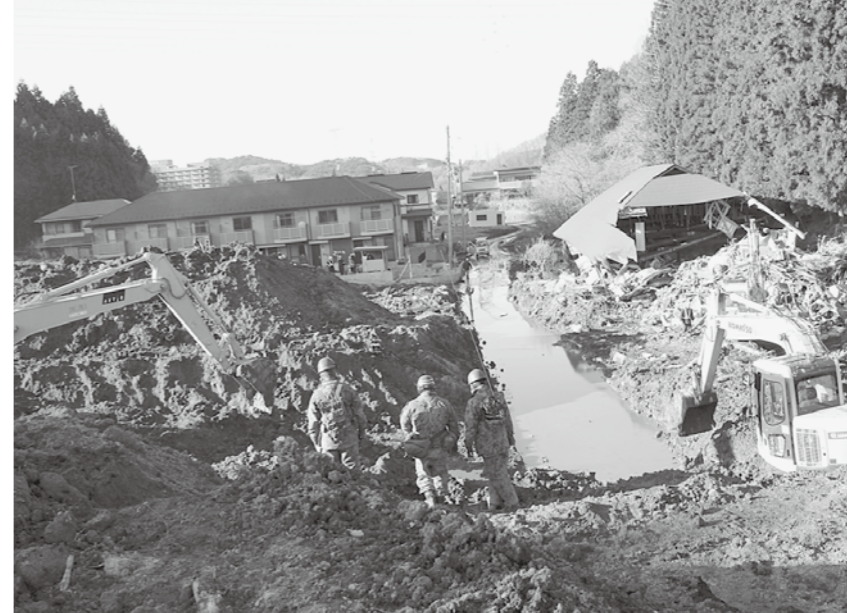
△山の崩落現場（葉ノ木平地区）
