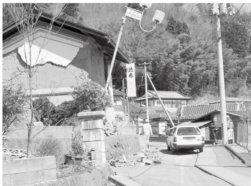
△蔵の外壁がはがれ、街灯が傾き、今にも倒れそうな様子（大信隈戸）
