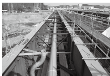
▲工事中の白河橋に設置された300mmの水道管
