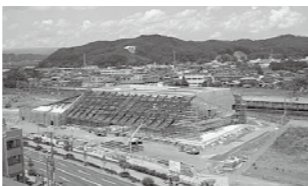
▲建設中の新図書館
