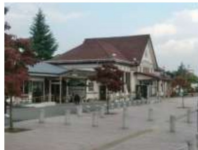
大正建築の白河駅舎(旧三の丸所在)
