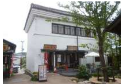
旧商工会議所建造物(中町)
