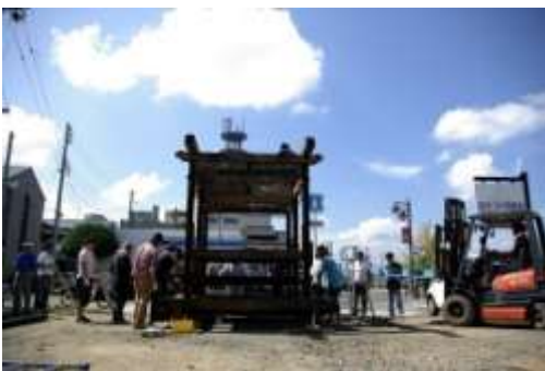
屋台の屋根組み立て準備
