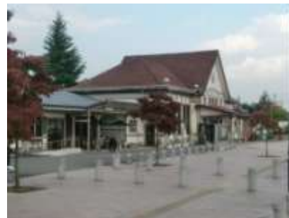
大正建築の白河駅舎(旧三の丸所在)
