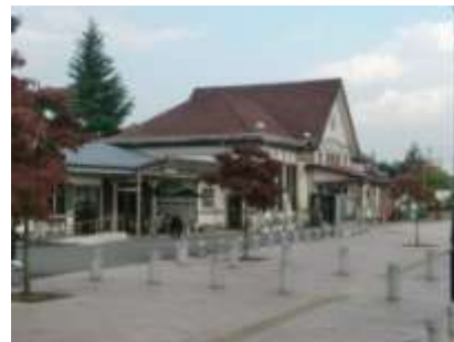
大正建築の白河駅舎(旧三の丸所在)
