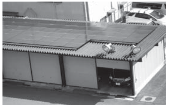
公用車車庫の屋根に設置された太陽光パネル
