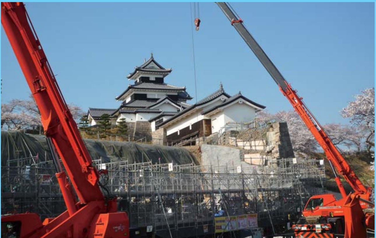
白河地域：石垣復旧が進む小峰城
