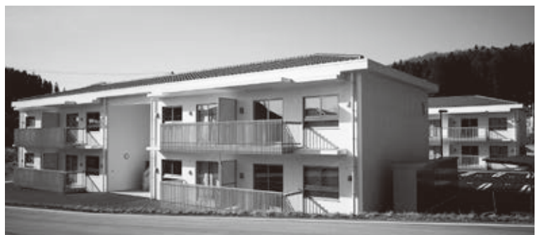
葉ノ木平災害公営住宅
