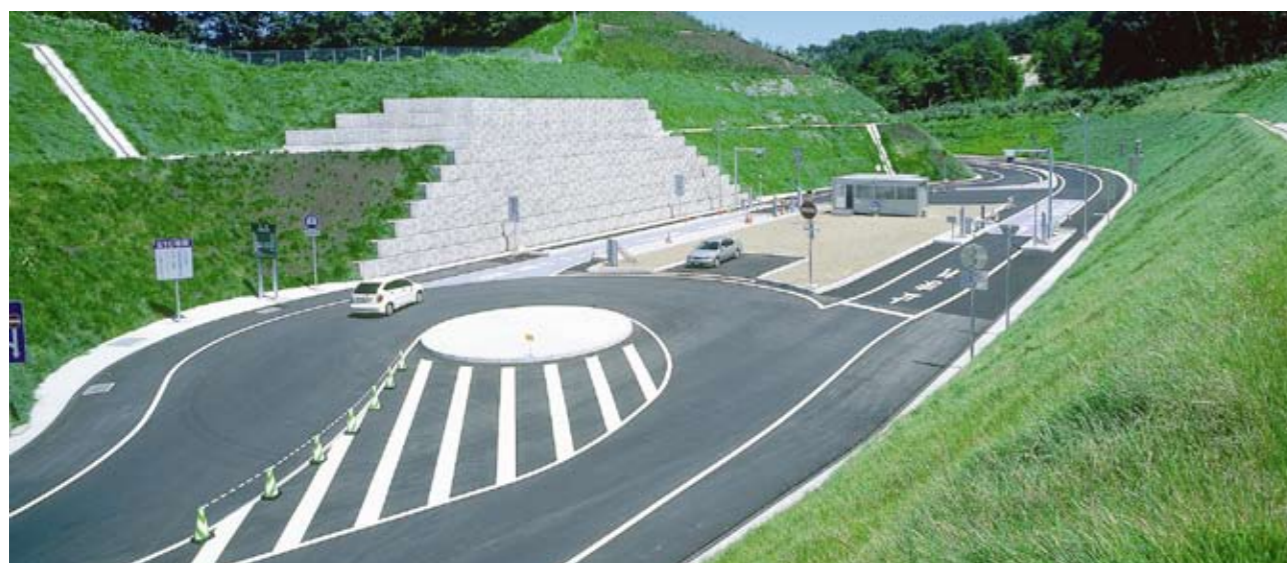
▲ 白河中央スマートインターチェンジ
